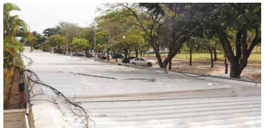
A primeira opção foi instalar telhados nos corredores
