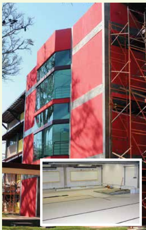
Prédio da Facom quase finalizado
