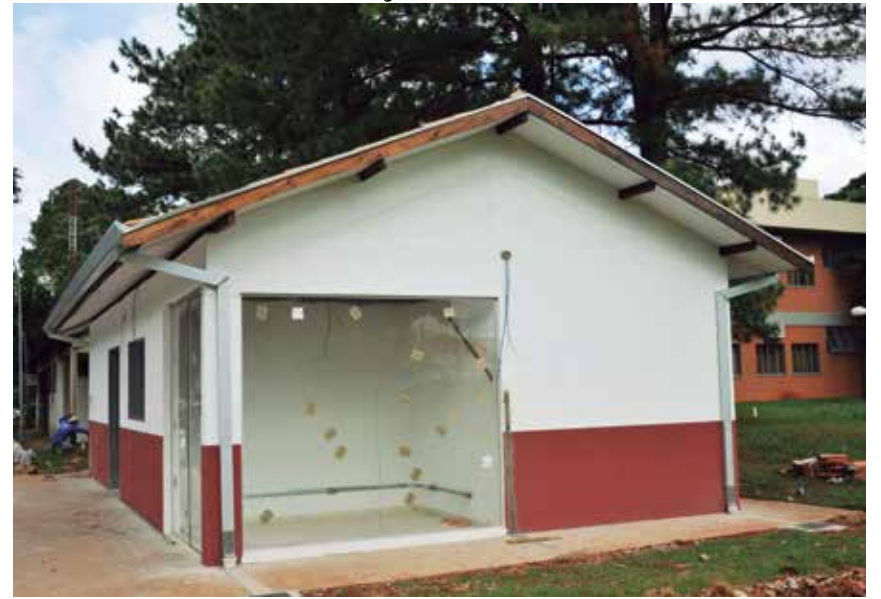
Obra da central de videomonitoramento, em fase de acabamento
