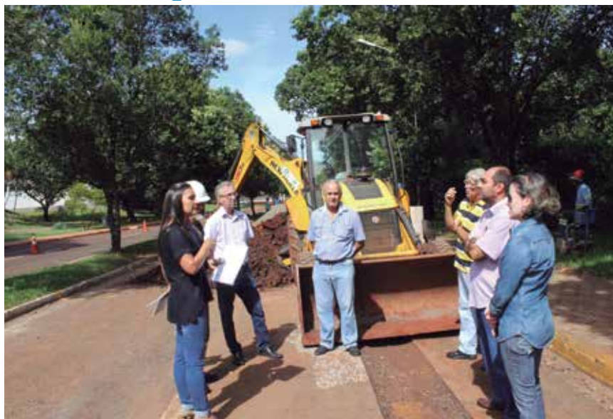
Obras atendem planejamento da Universidade para sustentabilidade
