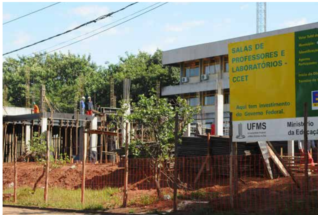
Construção de salas de professores e laboratórios do CCET
