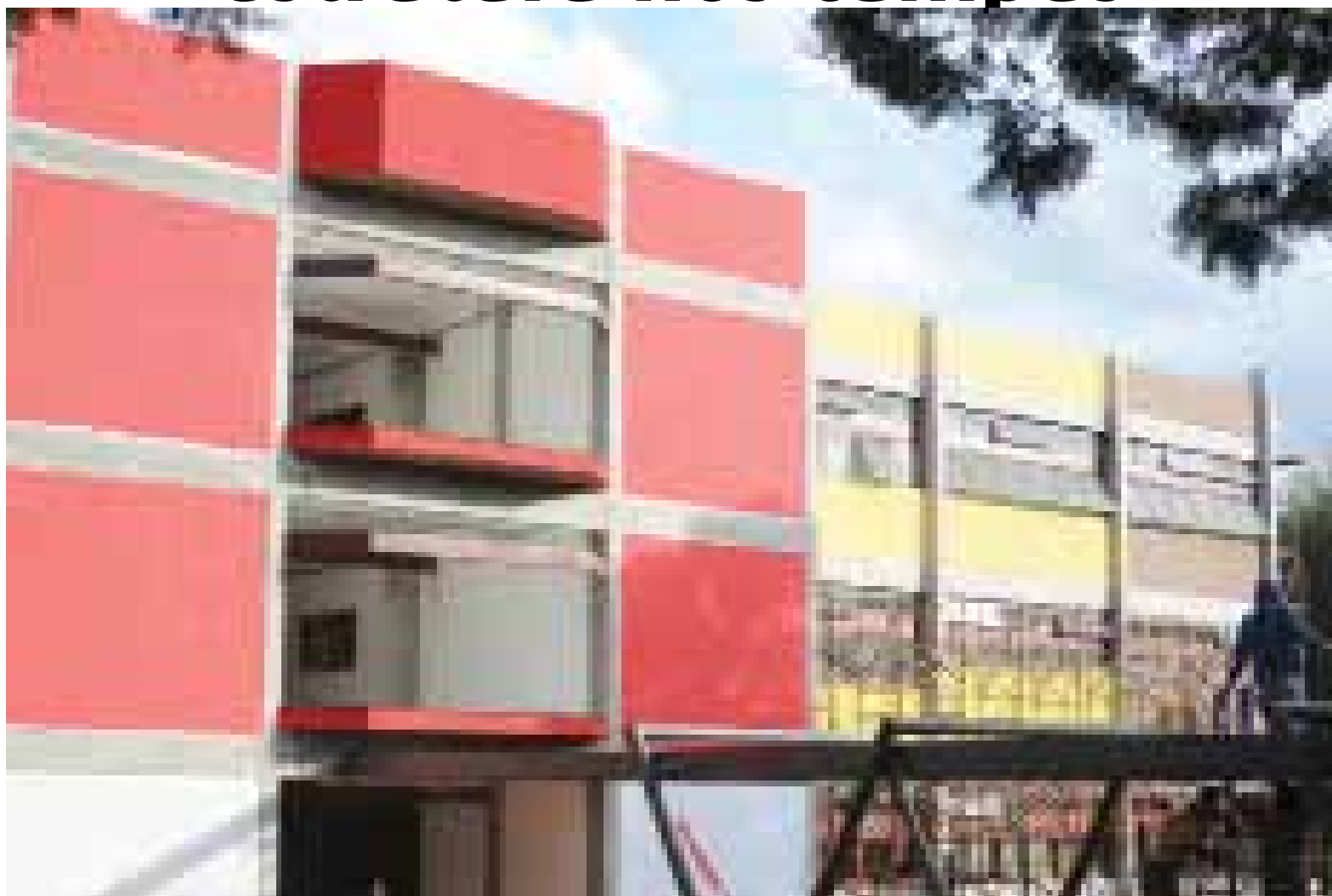
Em construção, o novo prédio que irá abrigar a Faculdade de Computação e atenderá aos cinco cursos que a compõem
