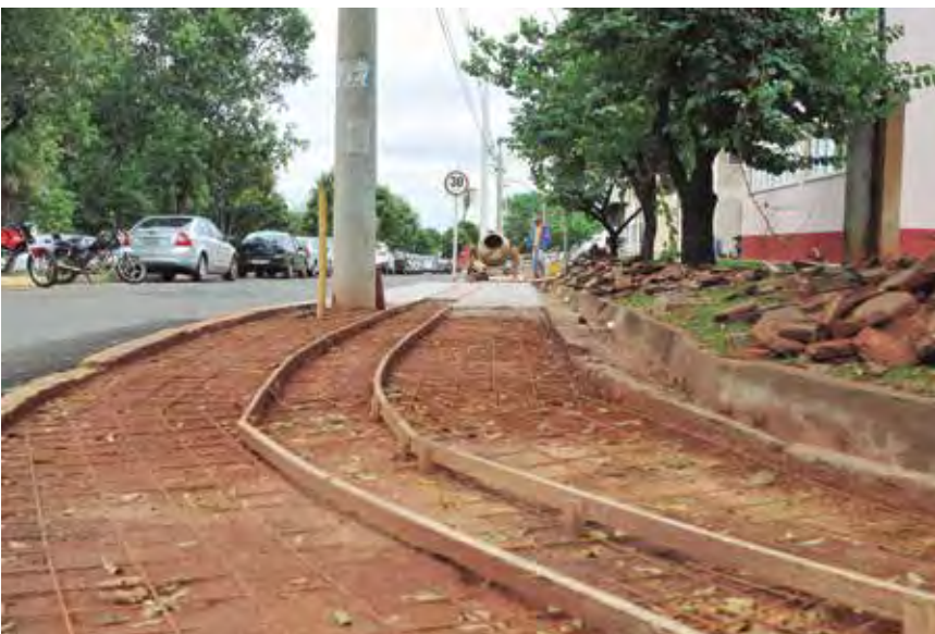
Rota acessível está sendo construída em Campo Grande
