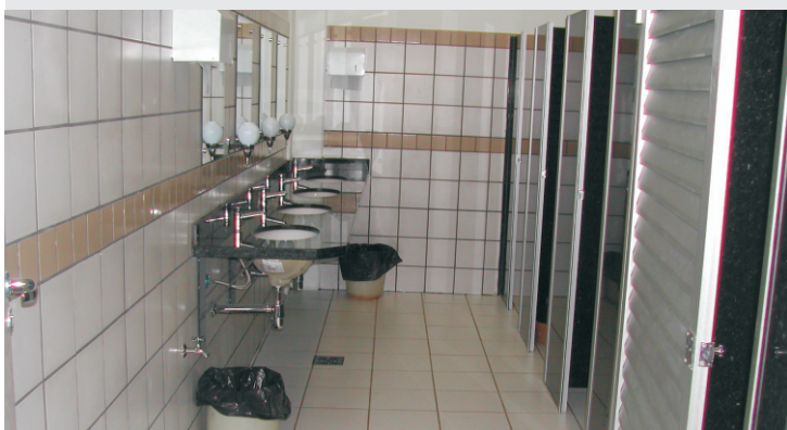
Banheiros reformados já foram entregues
