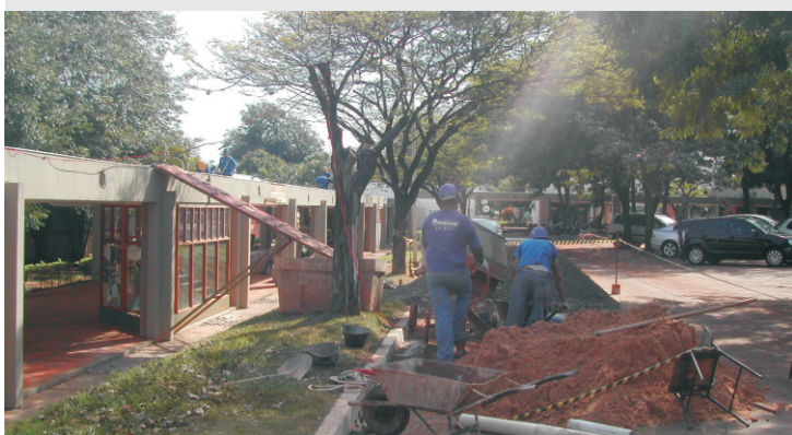
Troca de telhas revitaliza corredor central
